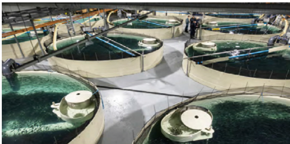
그림 2-2 | 스코틀랜드의 순환여과시스템(RAS) 양식장 사진
