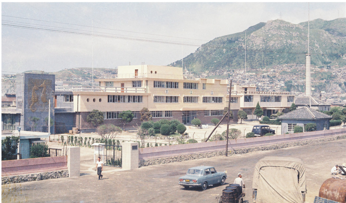
1966. 10. 20. 국립수산진흥원 본관 건물 신축(부산광역시 영도구 남항동)
