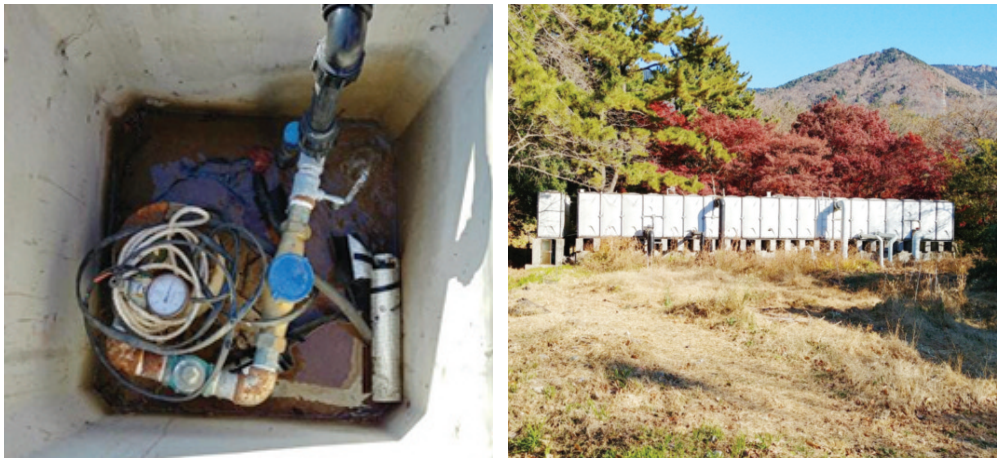
그림 3. 지하수 취수를 위한 심정펌프(좌)와 지하수 저장탱크(우).
