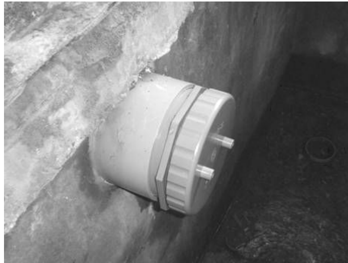
그림 Ⅲ-7. 해삼종묘생산 사육수조의 해삼 포집을 위한 배수구 (중앙배수로부터 작업할 수 있고 수조내 중앙배수구로부터 사육수가 배출 될 수 있도록 설치)
